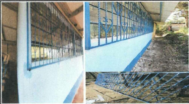
Foto1: Fabricacion e instalacion de balcones de metal
