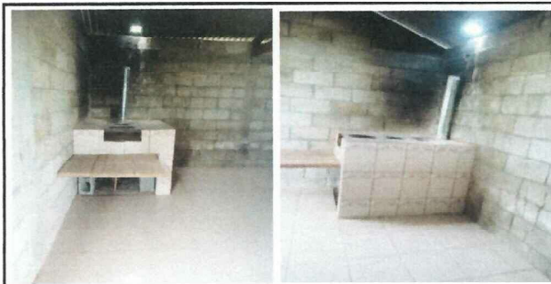
Foto 5: Mejoramiento de polleton e instalacion de plancha.
