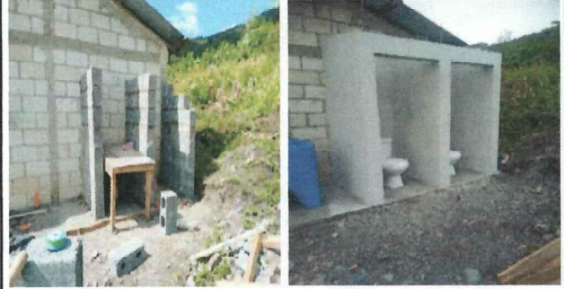
Foto 4: Construccion de pared formal de block baño e instalacion de letrinas.
