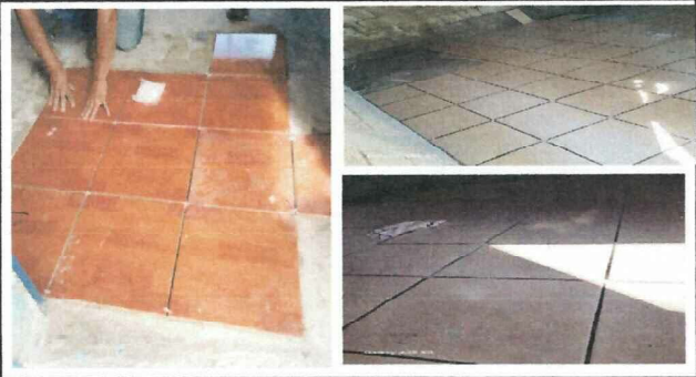
Foto 2: Instalacion de piso ceramico en el aula.
