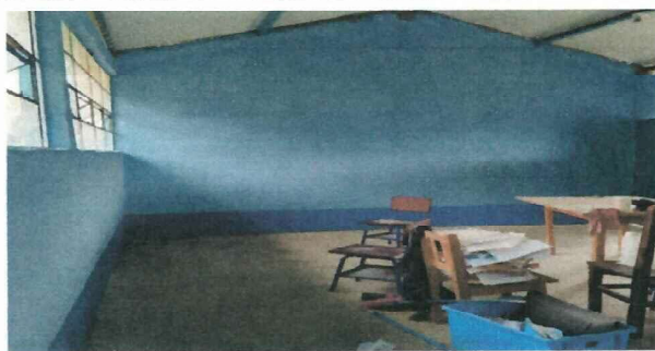
Foto 3: Cernido de paredes con monocapa interior y exterior del aula.
